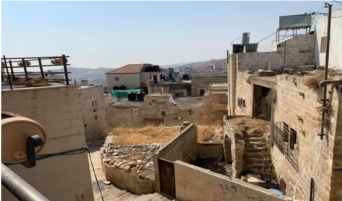
صورة (11) إهمال وهجرة بعض المباني القديمة الواقعة في حارة القواوسة
